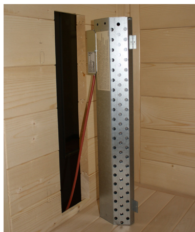
Fig. 2: Posición de la caja de conexiones
